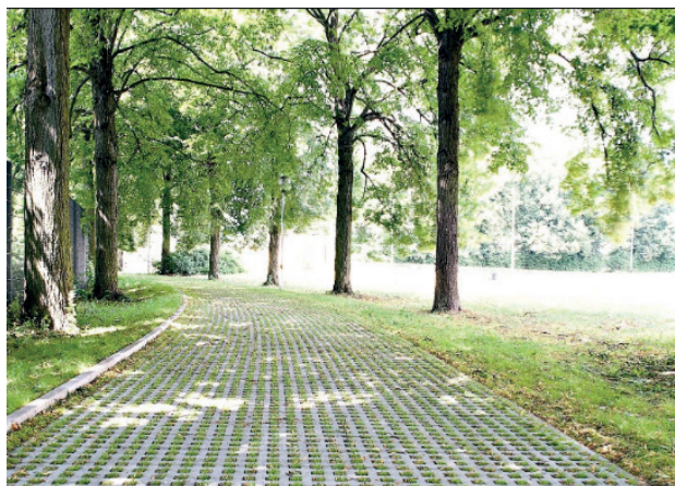
Revêtement de circulation douce semi-perméable
