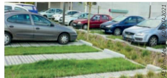
Noue végétalisée avec infiltration gravitaire du ruissellement, et aménagement favorable aux mobilités douces
